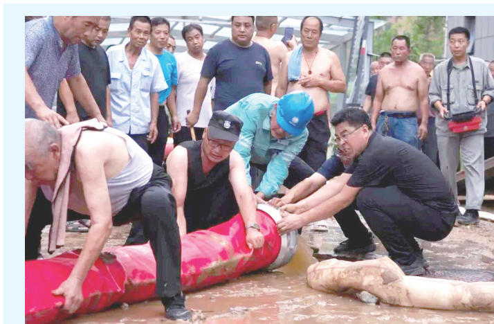
一台“龙吸水”在阜平县面积最大的安居家园小区以每小时3000立方米的速度抽排地下室积水
