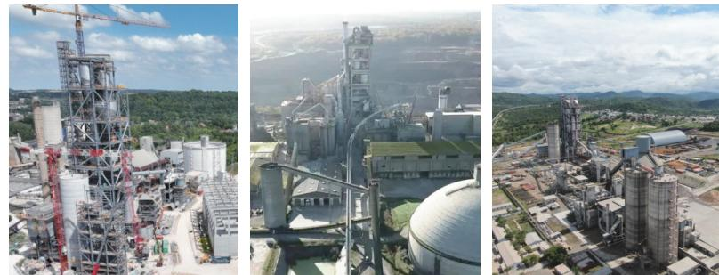
近日，中材建设承建的欧洲首条工业化全氧燃烧水泥熟料生产线——法国K6项目预热器塔架钢结构顺利实现封顶。
