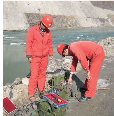
科研团队成员在施工现场
