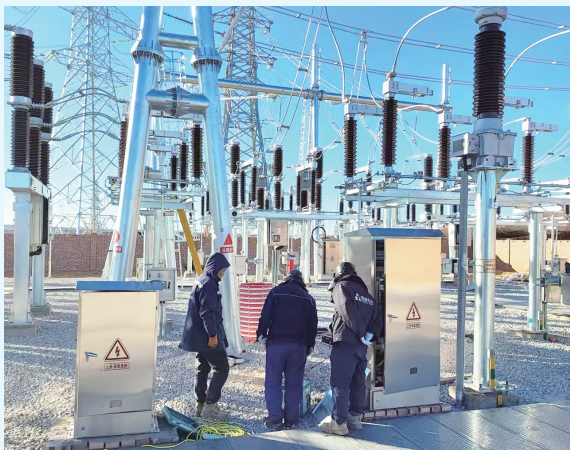
项目建设现场
