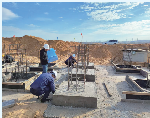
项目建设现场
