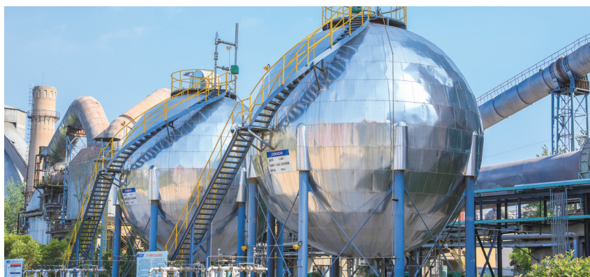
海螺集团白马山水泥厂水泥烟气捕集纯化二氧化碳储存罐 黄勇/摄
