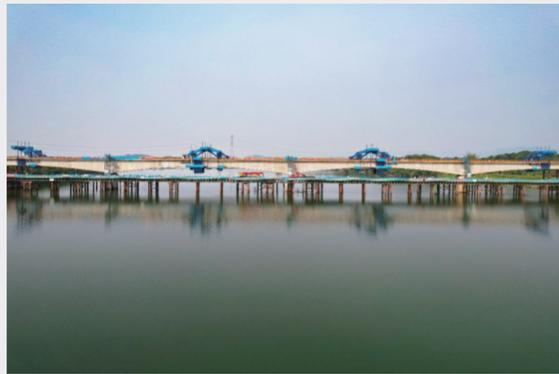
3月29日,由广东铁投集团所属揭惠铁路公司投资建设、中铁四局施工的揭(阳)惠(来)铁路全线重点控制性工程榕江南河特大桥主跨连续梁顺利合龙,为工程全线贯通打下坚实基础,也为全线架梁和铺轨创造条件。为确保主跨顺利合龙,施工方中铁四局科学组织、精心统筹,保证现场各项工序衔接到位。浇筑过程中,还增派技术员、试验员和安全管理专员全程盯控、严格把关,对浇筑施工各个阶段情况进行跟踪观测和适时调整,尽可能将施工偏差控制在15毫米以内,确保混凝土浇筑质量符合要求。
