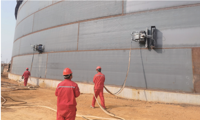
罐壁机器人施工
