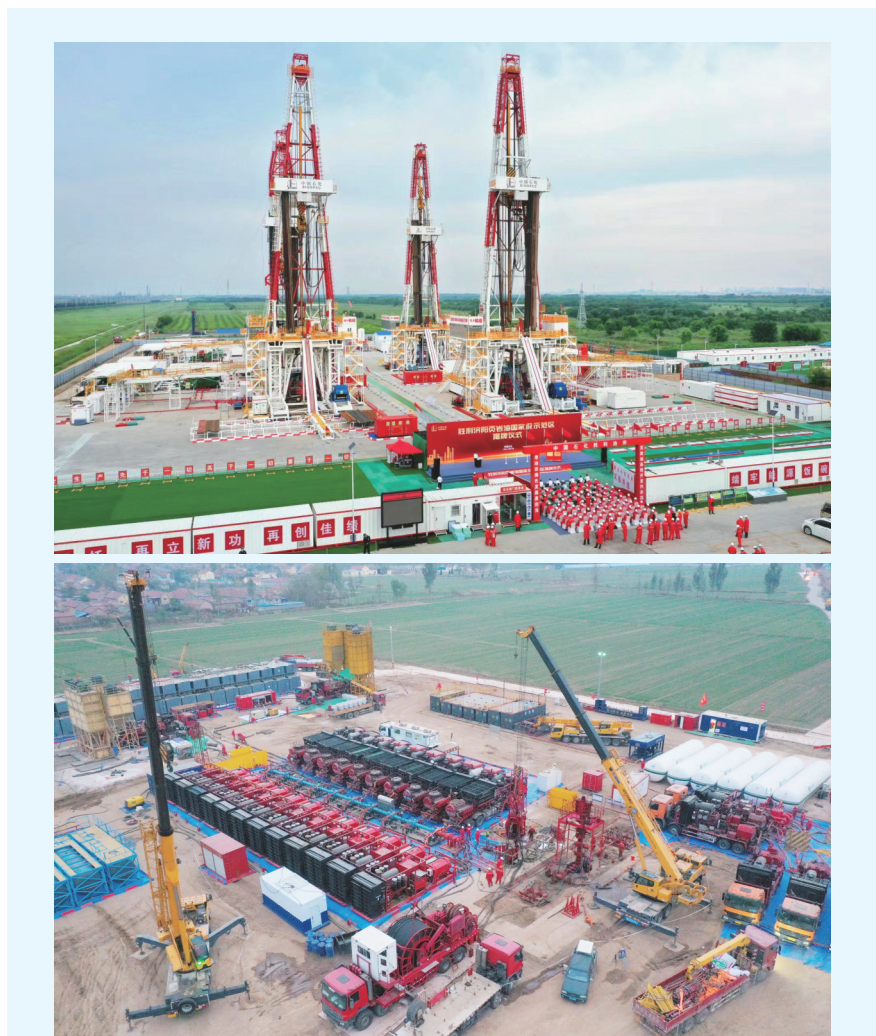
胜利油田在中国石化页岩油勘探重点探井——樊页平1井压裂施工。15天完成压裂,峰值日产油171吨,日产气14491立方米。
