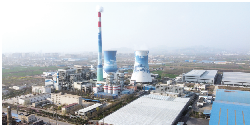
建设在发电厂里的番茄蔬菜工厂,农业碳中和示范基地。
