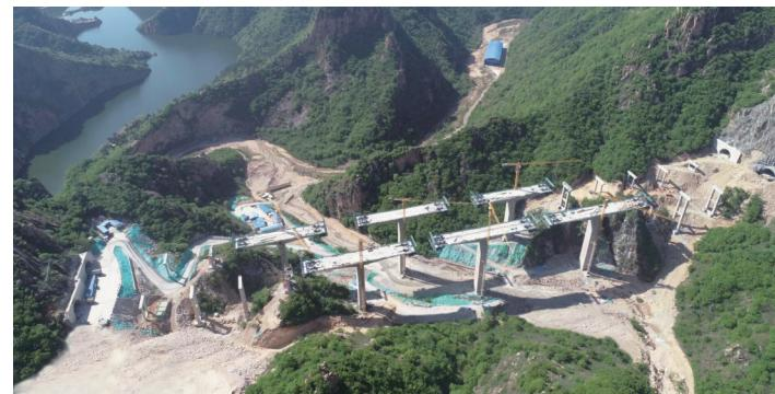
施工,优先对梁场段内的两道涵洞进行作业;涵洞工程采用半幅施工,优先保证右半幅路基贯通;配备充足的路基施工资源,前期人工配合运输炸药,充分利用夜晚时间予以运输、破碎,白天进行钻孔、摊铺碾压;为保证填方路段的沉降以及挖方边坡的稳定,项目定期对沉降观测点进行观测,确保数据及时有效。
