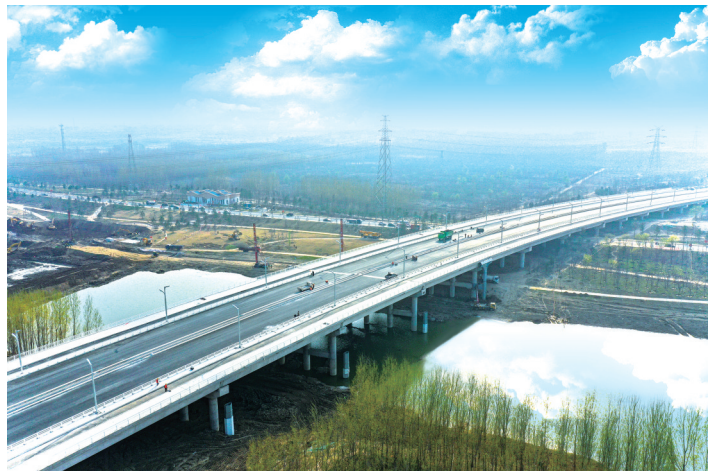
白沟引河大桥
