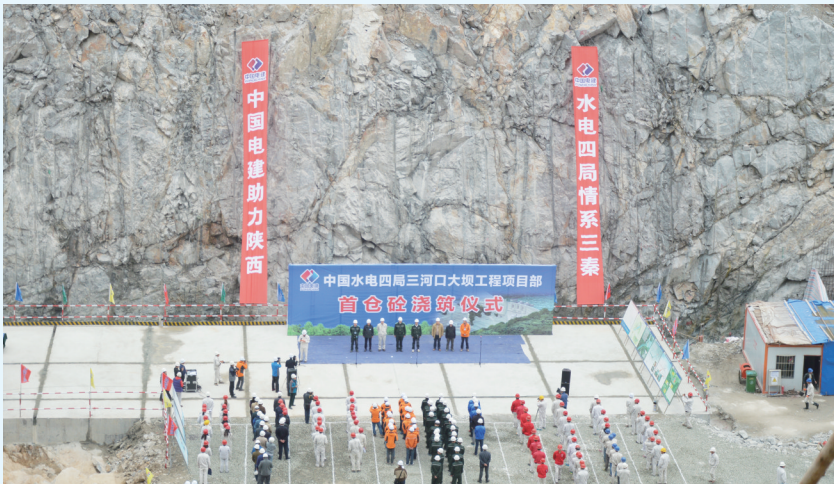
首仓碾压混凝土浇筑
