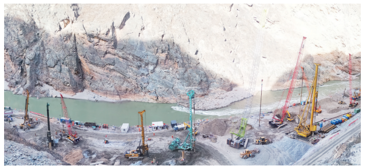
拉哇水电站——世界最深振冲碎石桩施工现场
