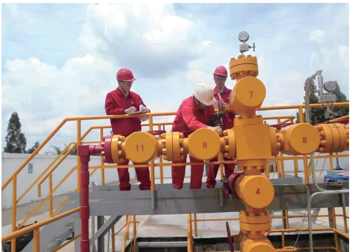
天然气井安全管控与隐患治理研究团队开展现场检测
