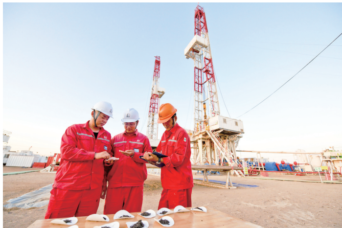
中国石化胜利石油工程公司40600队正在进行义34-斜230井施工 王福/摄
