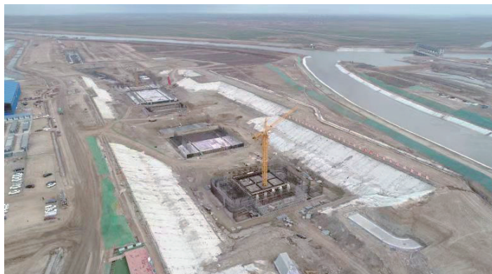
小清河复航工程施工四标三工区王道船闸施工现场
