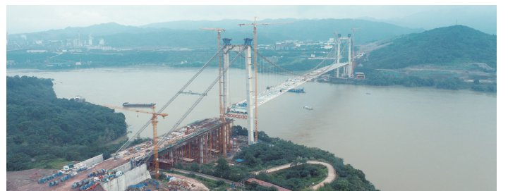
建设中的重庆长寿长江二桥
