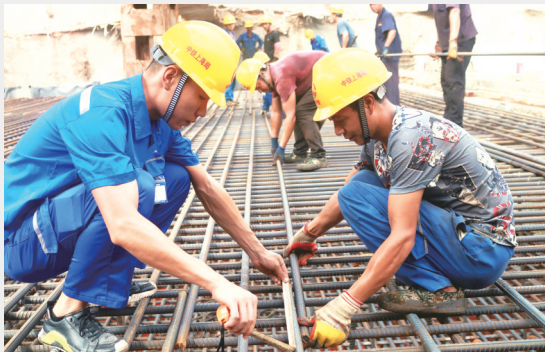
图为9月19日结构班组技术负责人杨建现场指导作业人员钢筋衔接绑扎
