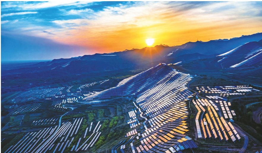
山西全力推动能源革命综合改革试点工作,大力发展新能源产业。图为5月9日,无人机拍摄的运城市芮城县光伏二期建设工地陌南15万千瓦光伏项目。 薛俊/摄
