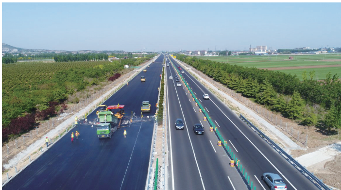
公司项目济青高速改扩建工程施工中
