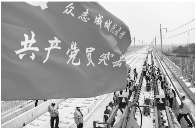
2月25日，合安高铁恢复铺轨施工，图为作业人员放置滚筒。
