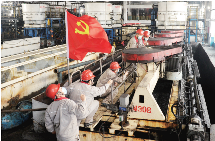
3月6日，淮北矿业集团临涣选煤厂党员突击队员正在生产现场进行安全隐患排查。 陈磊 石启元/摄
