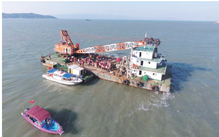
对海底电缆进行抢修
