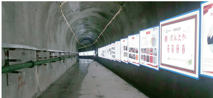
大坝基础灌浆文化长廊
