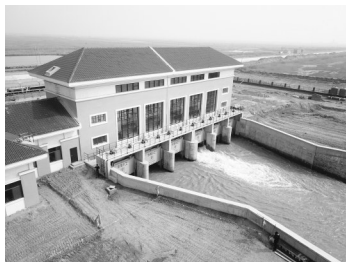
曹店入沉砂池泵站
