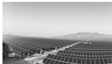
沂南光伏电站厂区
