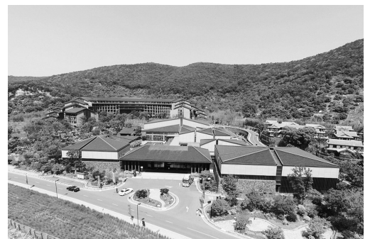
中建八局—酒店会议中心项目航拍图
