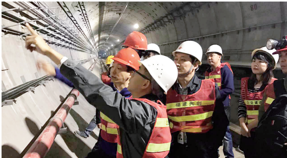
施工前反复调研考察,实现地上地下全信号覆盖
