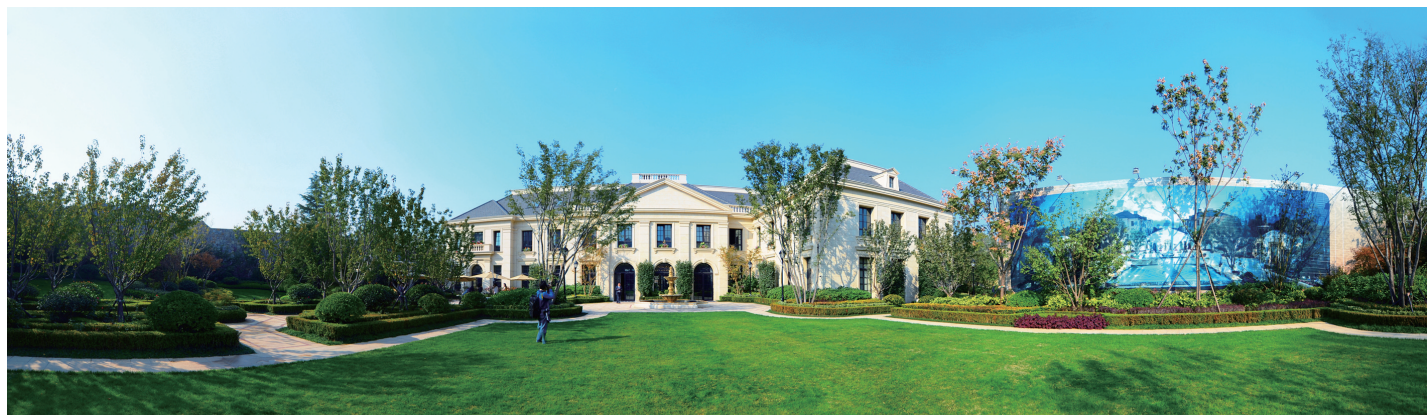
腊山御园修复工程实景
