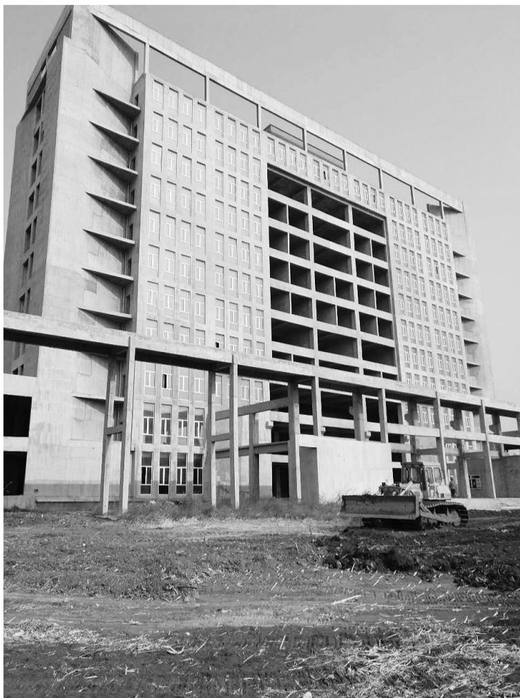
图为在建中的沈阳石油产品交易中心大厦。 崔业波/摄
