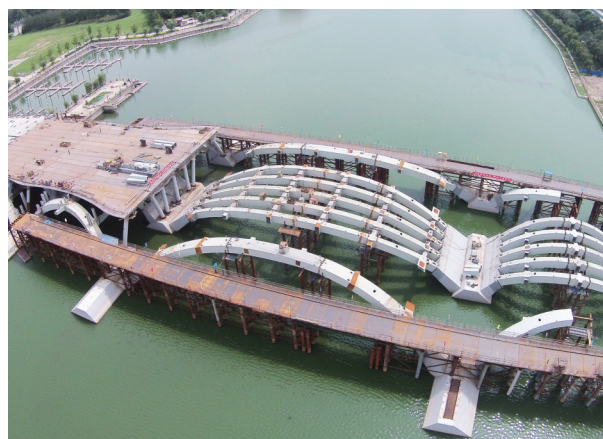
北京通州运河核心区市政配套工程北关大桥北运行河桥梁工程
