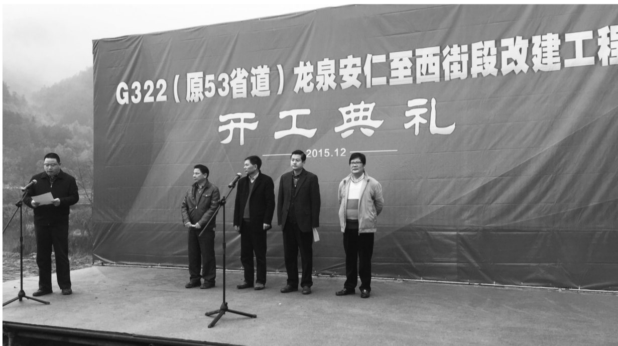
G322龙泉安仁至西街段改建工程开工典礼
