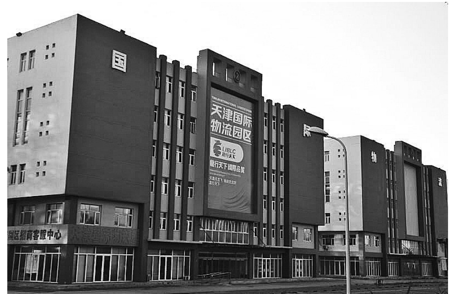
天津国际物流园招商办公大楼
