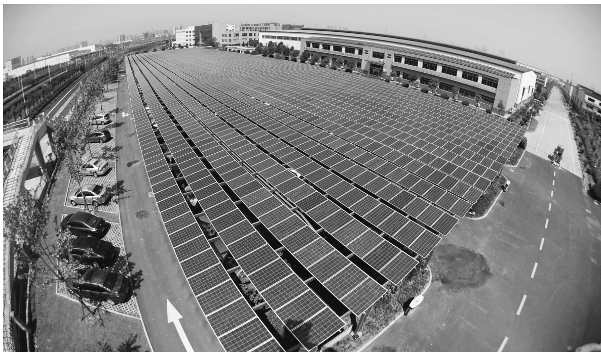
位于合肥经开区的安徽合力股份有限公司建成全省最大面积光伏电站停车场,该停车场平均每年可提供约 80 万度的绿色电能。
