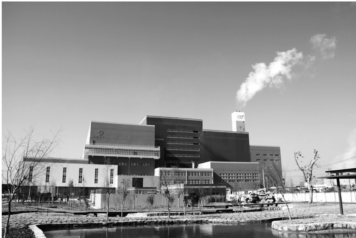
中国节能合肥公司厂区
