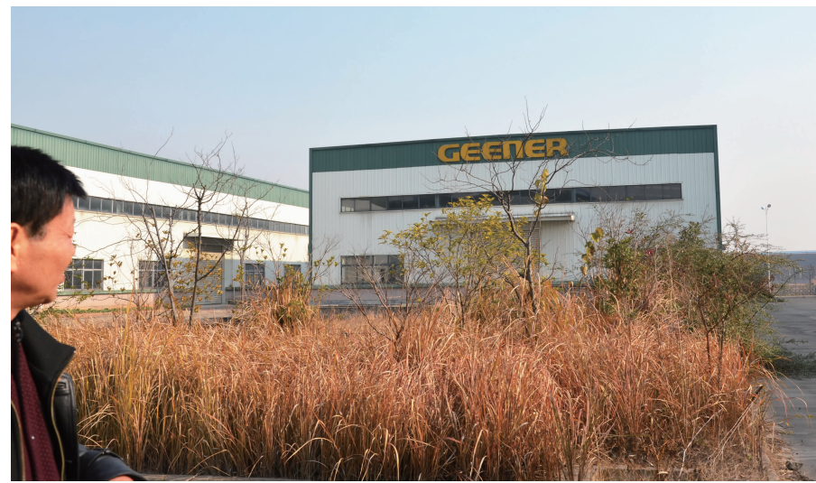
污水处理中心前荒草高一米多 本报记者 钟文/摄
