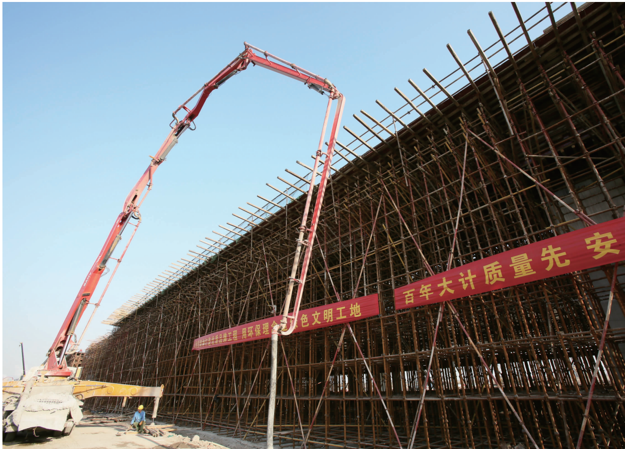
二公司承建的京津塘高速公路4标段施工现场
