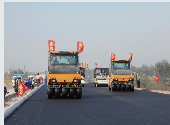
二公司承建的河南德商高速公路工程施工现场
