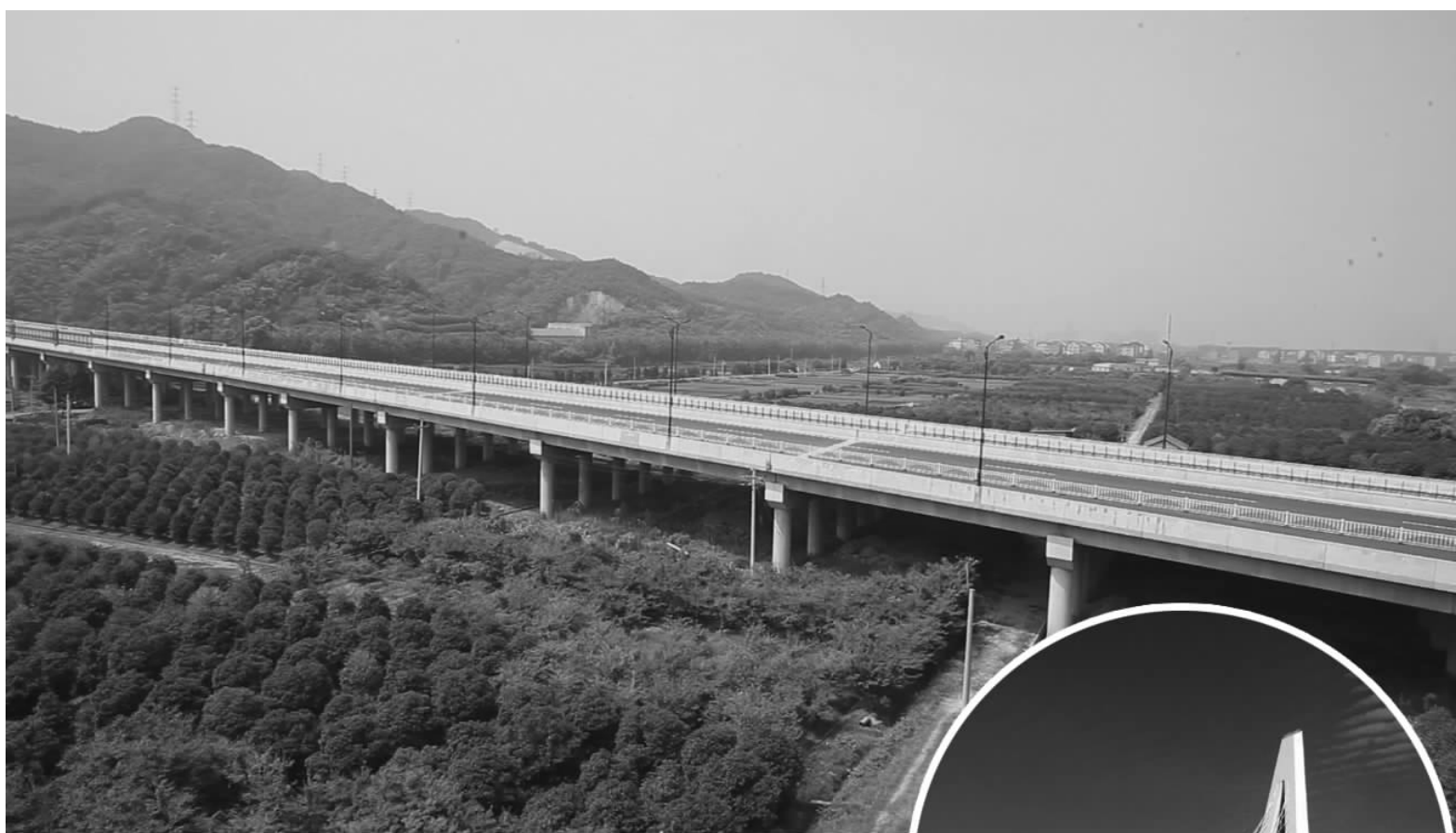
▲浙江03省道杭州绕城高速至萧山临浦段改建工程(BT) ▶承德市滨河新城起步区三纬路跨滦河特大桥
