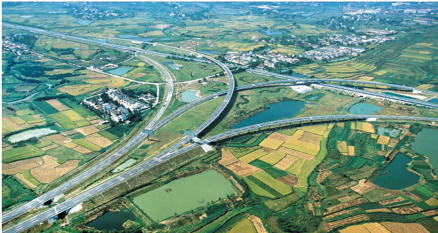
集团施工的安徽合宁、合安高速公路小西互通立交
