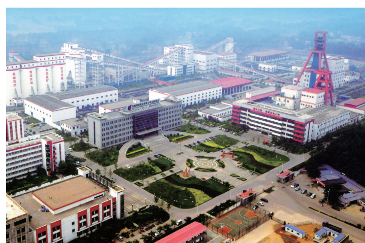
集团施工的山东赵楼煤矿,获国家优质工程奖
