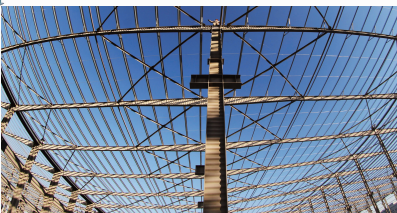
全国钢结构金奖工程全部采用波浪腹板建造
