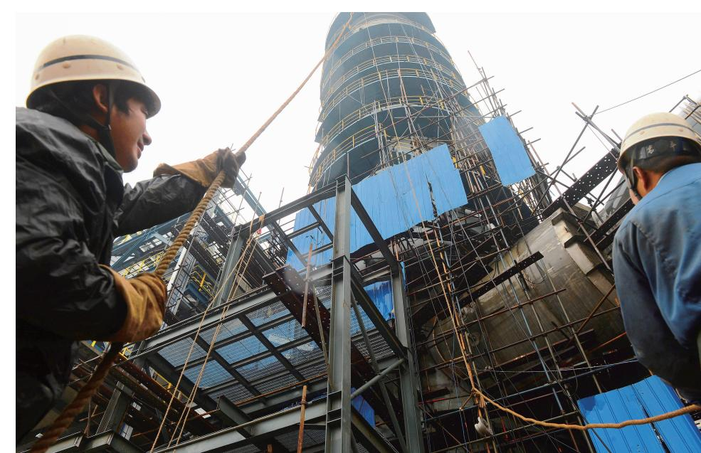
日前,中国石化青岛炼化“碧水蓝天”项目重点工程——290万吨/年催化裂化装置再生烟气脱硫脱硝改造项目进入建设收尾阶段。该项目总投资13391.58万元,占地1315平方米,设计处理烟气350000标立/时。整个项目预计12月份投入试运行。
