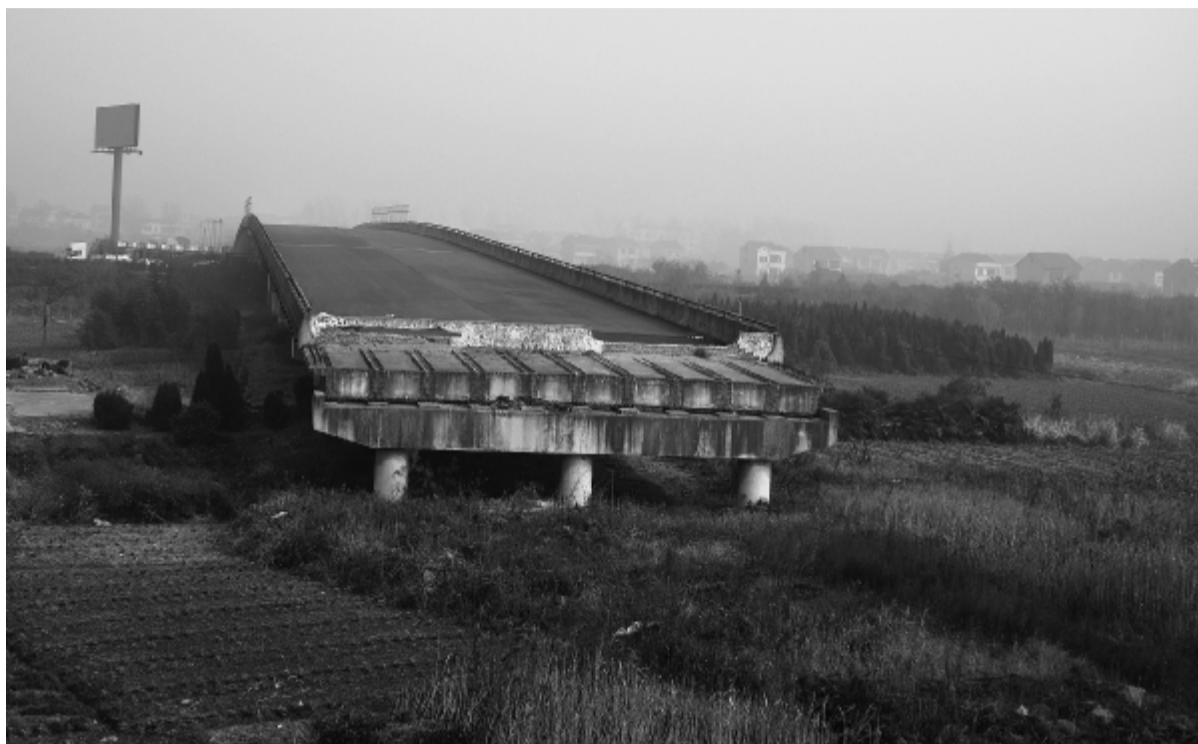
斥资千万元的政府工程，在横跨高速之后没多久，桥面就戛然而止了。 本报记者 钟文 / 摄
