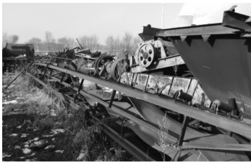
强拆后被损坏的企业设备
