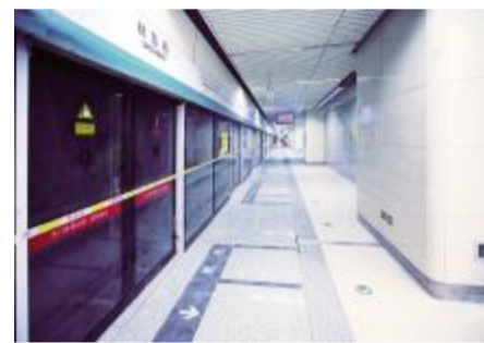
地铁8号线林萃站机电安装工程
