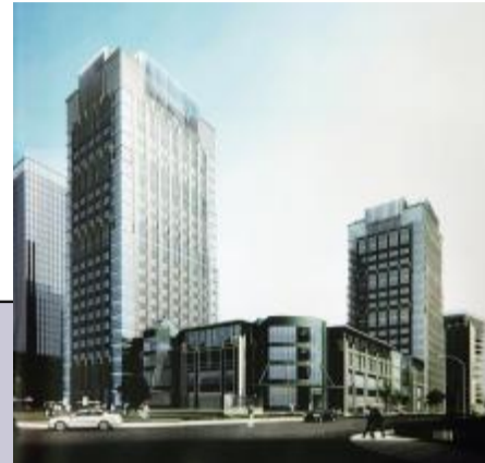
成都润都大厦在建工程
