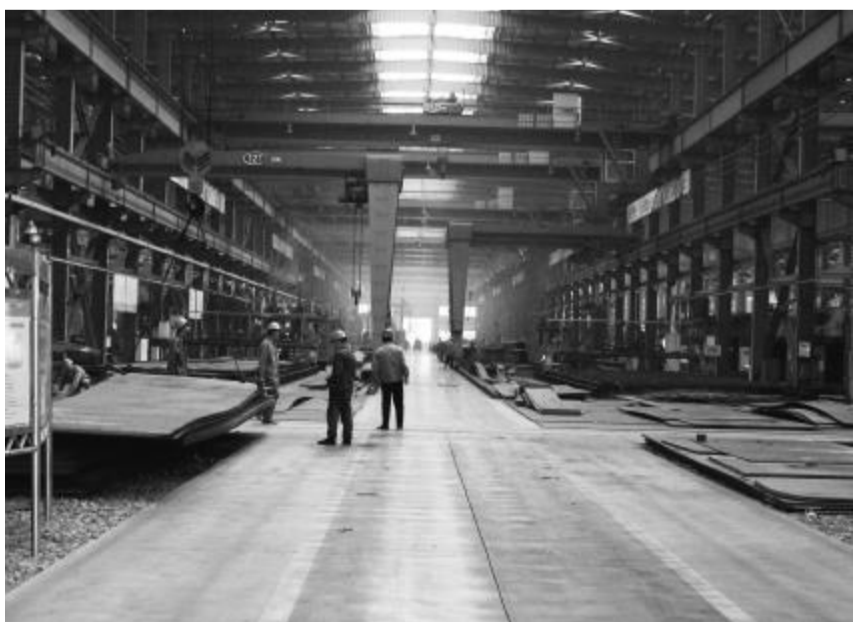
全部采用波浪腹板钢结构建设的华兴近十万平方米钢结构车间
