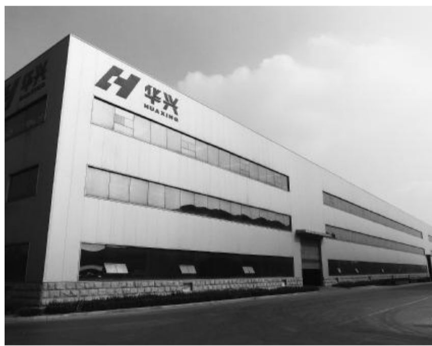
华兴钢结构厂房获得中国钢结构两项金奖
