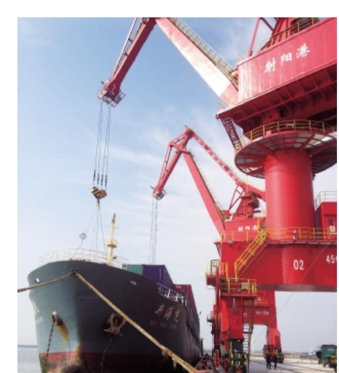
10月1日,江苏省射阳港万吨级航道通航。在中国交通建设总公司等多家单位支持下,一举攻克拦门沙,建成总长12.5公里南北导堤,疏浚深水航道7.2公里,实现3.5万吨级乘潮通航能力,打开了江苏中部沿海出海新通道。图为已建成的万吨级通用码头。
