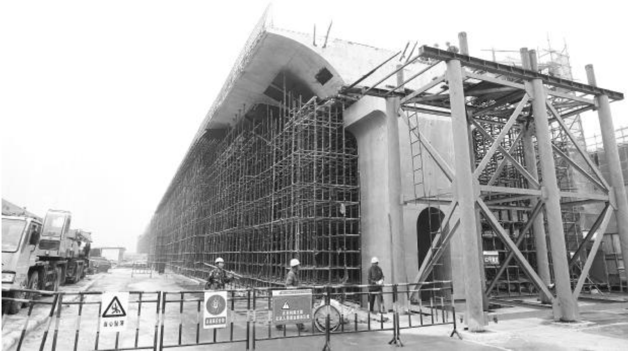
郑州三环项目北三环S21 联箱梁施工
