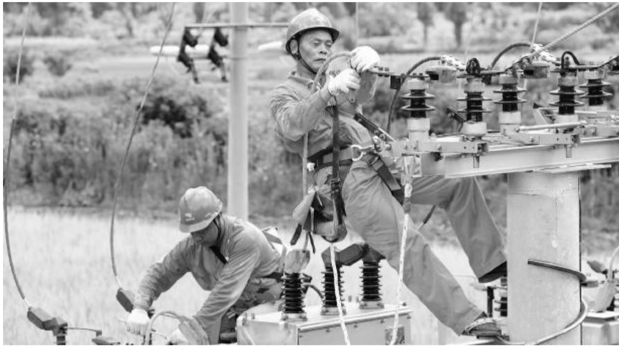
广西电网全力推进农村电网升级改造工作
