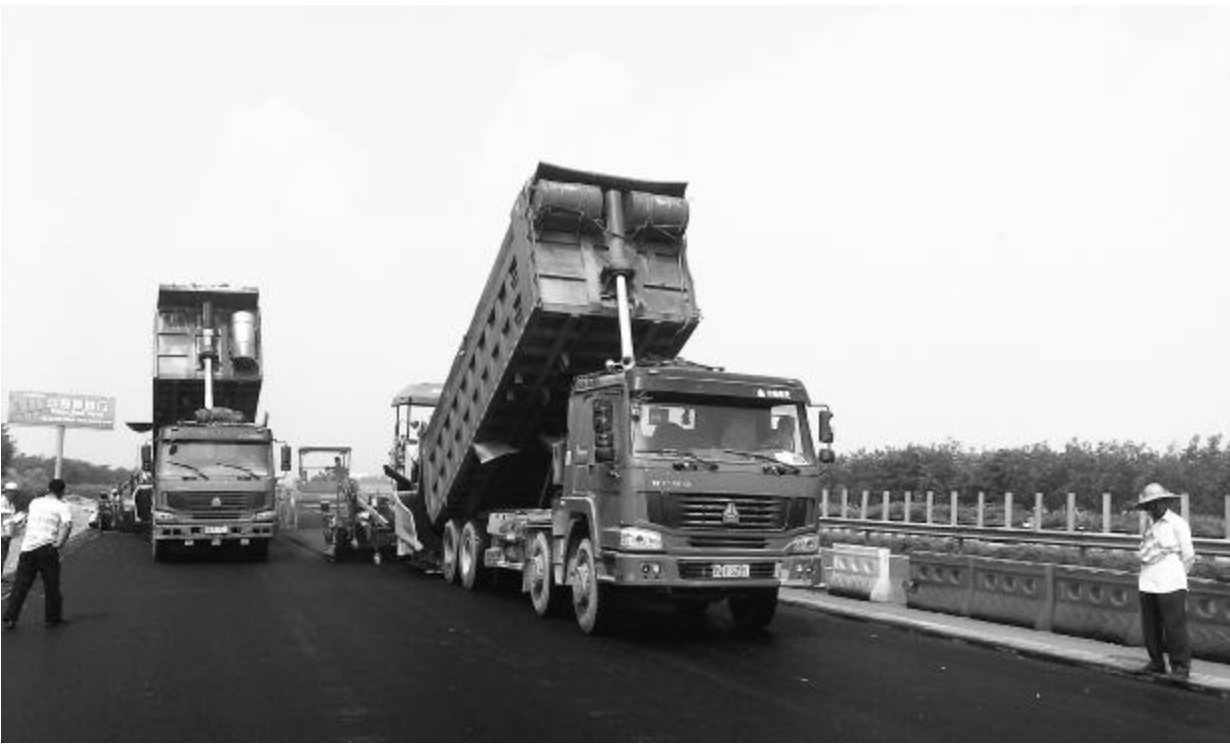
津汕高速22合同面层摊铺施工
