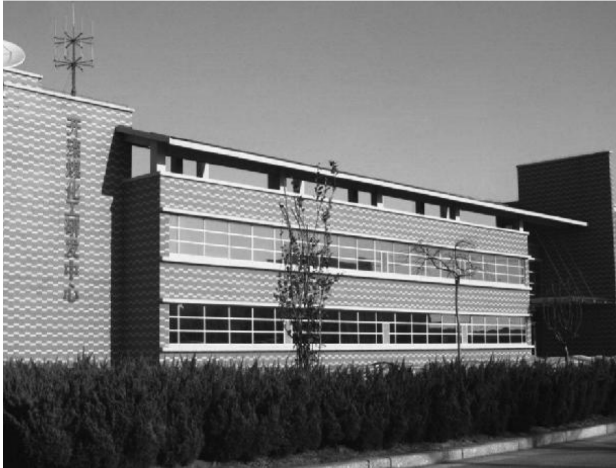
开滦煤化工研发中心外景
