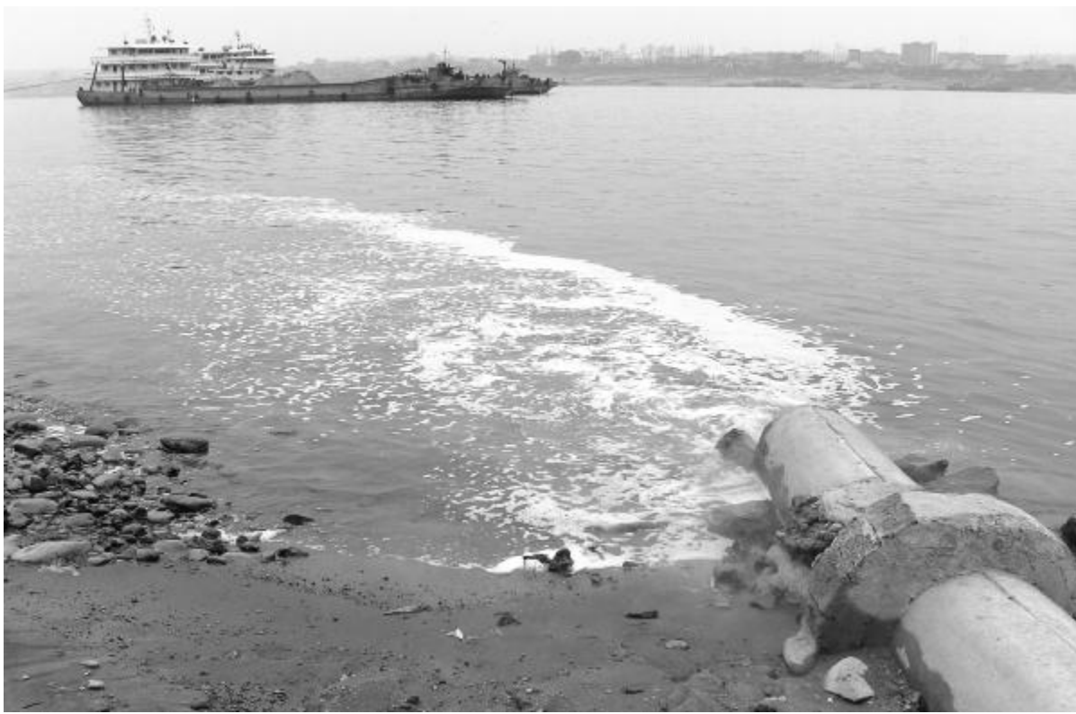
湖北某纺织印染厂向长江排放化工污水 CNS 供图
