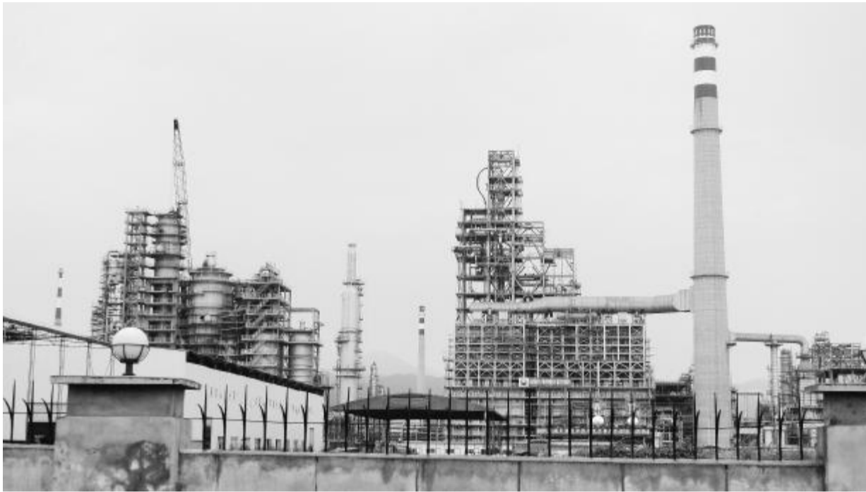
正在安装中的炼油设备
